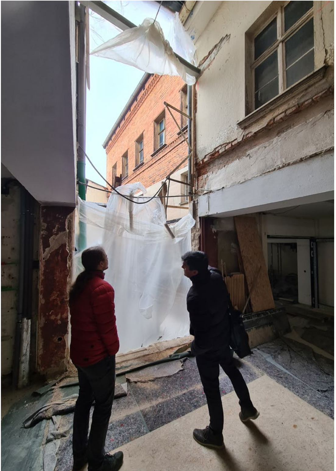
Planung (2022) und Umbau (ab März 2023) mit externem Architekten, Baufirmen und Freiwilligen.
